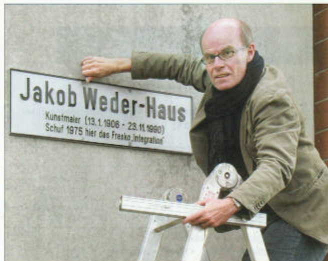
Samuel Gerber montiert am Wohnblock an der Brunnngasse in Herzogenbuchsee die Gedenktafel für Jakob Weder. (Bild: mh)
